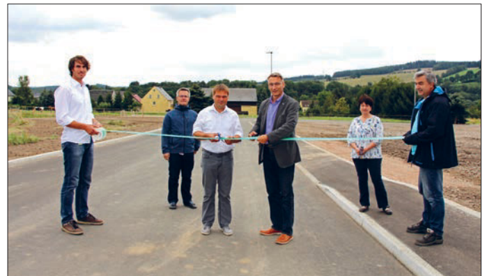
Oberbürgermeister Volker Holuscha eröffnete am 22. August 2017 gemeinsam mit dem Oberbauleiter der Wolf & Müller GmbH und Co. KG, ZNL Dresden, Ronald Piehl, den 2. Bauabschnitt des Gewerbegebietes OT Falkenau. Die Straße ist jetzt für den Verkehr freigegeben. Foto: SV Flöha
